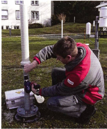
Figur 6: Alte Sonde wird ausgebaut.
