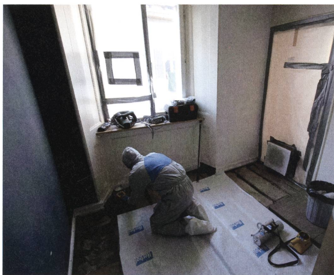
Figure 1: Assainissement d'un plancher contaminé au ^{226}\text{Ra} à La Chaux-de-Fonds.
