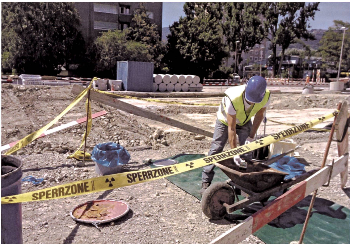
Figure 3: Triage der radiumkontaminierten Abfälle bei den Aushubarbeiten in der ehemaligen Deponie Lischenweg.
