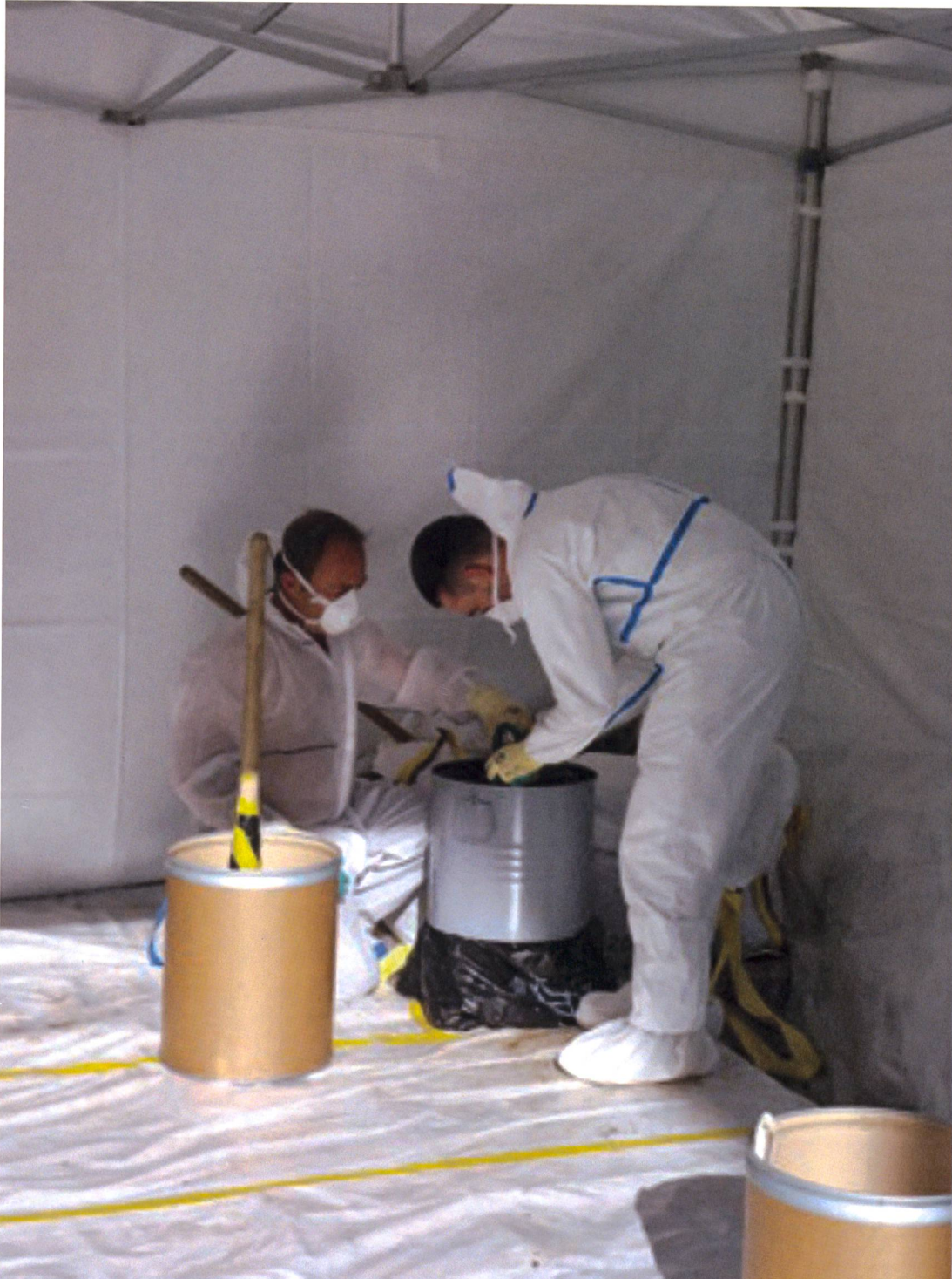
Figur 2. : Konditionierung von stark mit ^{226}\text{Ra} kontaminierter. für die Entsorgung im Bundeszwischenlager.
