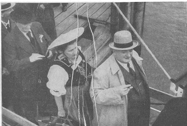
Die Schiffsbrücke unter „Belastungsprobe“.
