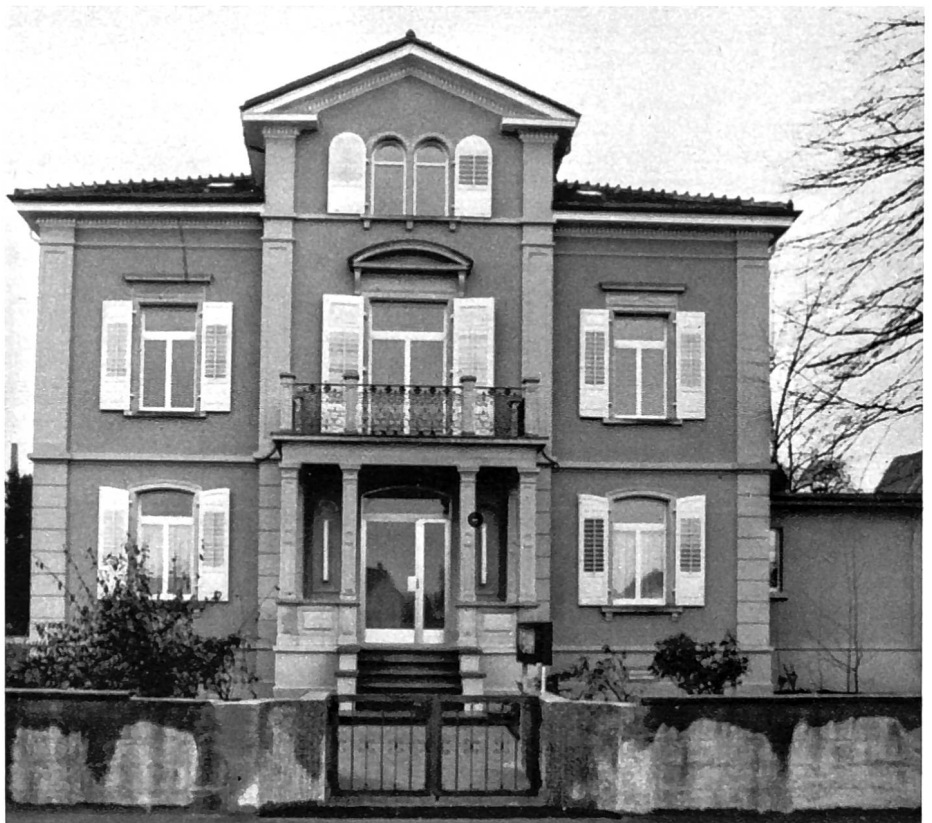
Die Raiffeisenbank Bürglen, von der Weinfelderstrasse her gesehen; rechts der Tresoranbau.
