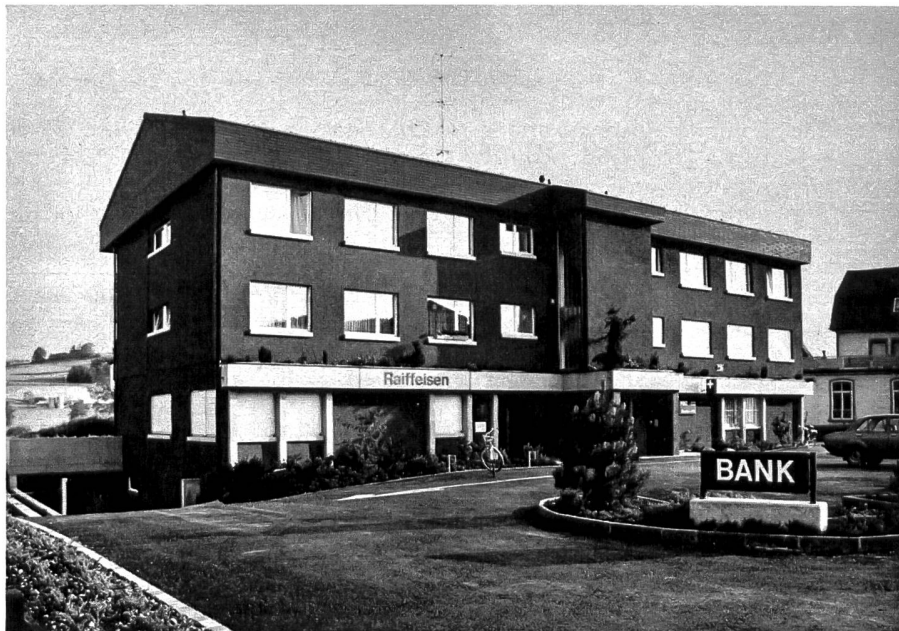
Neubau: Raiffeisenkasse Eschlikon links, Post rechts.
