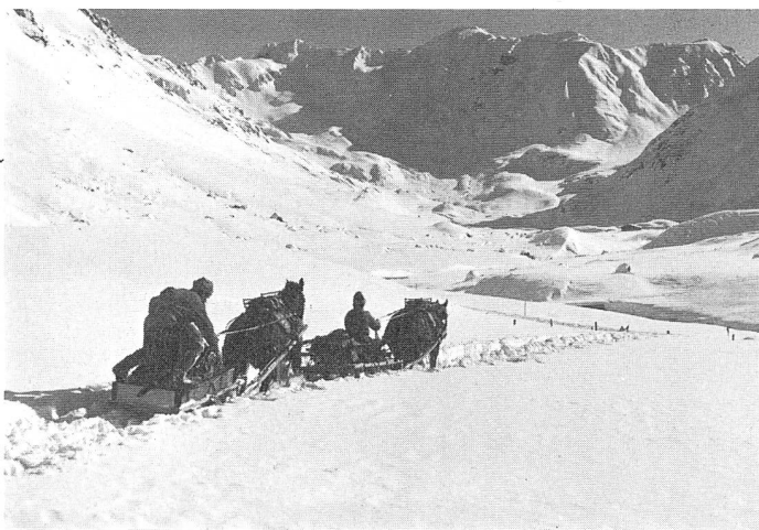
Die fertig geruttnerte Schlitten- und Saumpiste sollte annähernd gleich hoch sein wie die umgebende Schneedecke, damit sie nicht vom Winde verweht wird. Sie benötigt ständigen Unterhalt.
