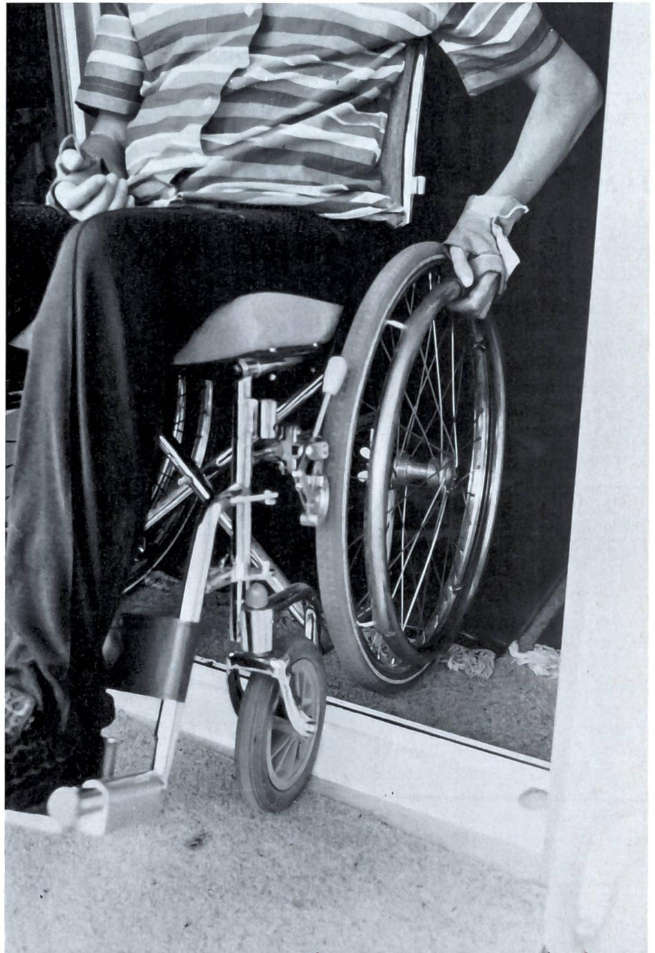
Empa-geprüfte Balkontüren mit Schwellenhöhe von 25 mm sind heute standardmässig erhältlich.
