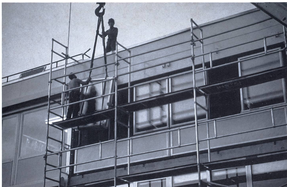
Ersetzen einer Platte auf dem Gebäude des LESO: jede Fassade enthält drei verschiedene Systeme von Solarenergie. Ein Dutzend Fassaden wurde im LESO bereits getestet.
