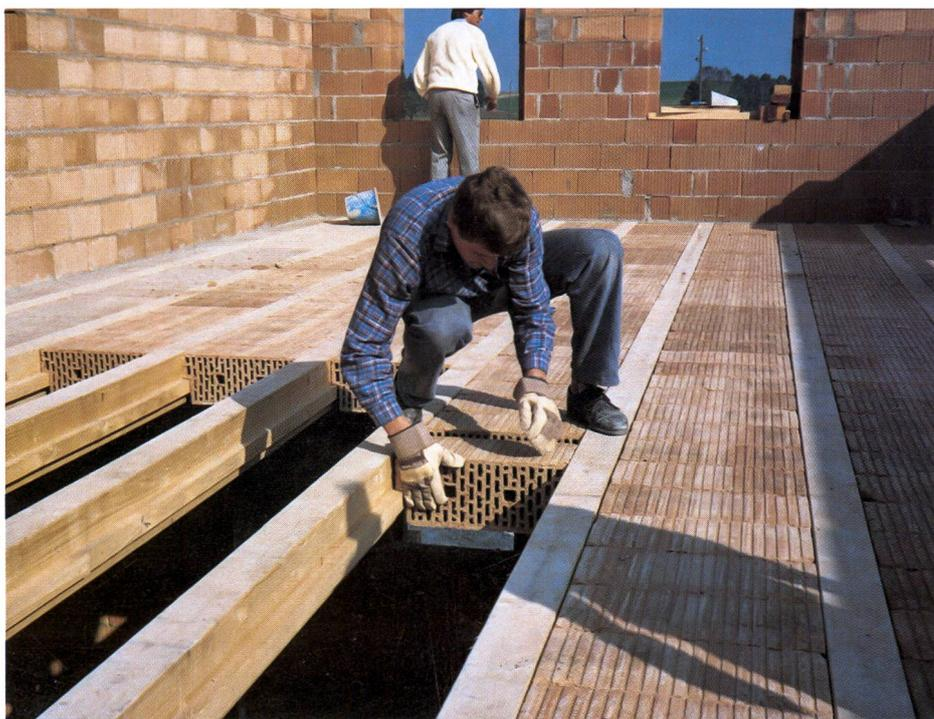
**Es muss nicht immer Beton sein. Im baubiologisch gebauten Haus wird mit Holz und Backsteinen gearbeitet. Angenehmes Arbeiten beim Erstellen einer Ton-Hourdisdecke.**
