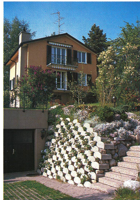
Stützmauer mit trocken verlegten Löffelsteinen, bepflanzt mit Erdbeeren.
