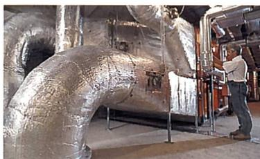
Imposant sind die technischen Eingeweide des Hochsicherheitsgebäudes; hier ein Blick in die Ausenluft-Aufbereitungsanlage des Labortrakts.
