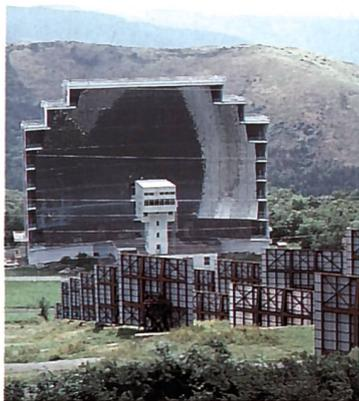
sich ein grosser Spiegel, mit dem eine Maximaltemperatur von 3800 Grad erreicht wird: Die Grösse der einzelnen Spiegel ermöglicht einen Energiefluss von total 1000 kWh. Mit diesen hohen Temperaturen, die durch Elektro- und Magnetfelder er-
