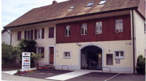
Erstrahlt in neuem Glanz: Die Geschäftsstelle Härkingen der Raiffeisenbank Zentralgäu.
