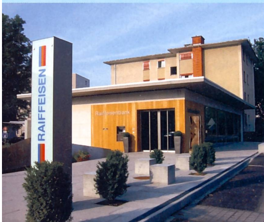
Die RB Biberist: einladend schon auf dem Vorplatz.
