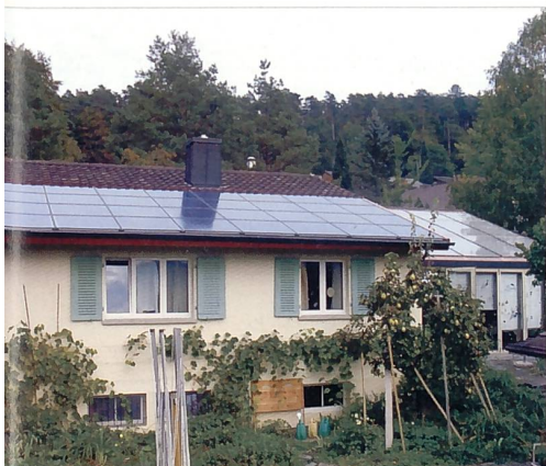
Sonnenkraftwerk statt Dachziegel: Reiche Ernte im Solarhaus der Familie Baumann in Neftenbach.
