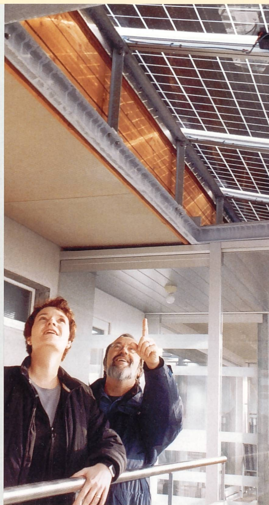
Martina Hüsler und Urs Bühler vom Verein energienetz-zug begutachten im neuen Mehrfamilienhaus der Genossenschaft AWZ eine Solarstromanlage, die auch der Beschattung dient.
