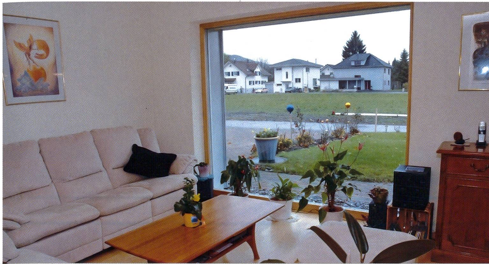
Die dreifach verglasten Fenster der Südfassade lassen viel passive Sonnenwärme herein. Die Holz-Metall-Rahmen isolieren optimal.
