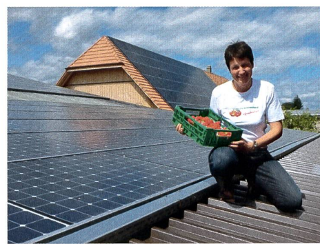
Auf dem Familienbetrieb von Barbara Schwab-Züger wird durch die Photovoltaik-Anlage der gesamte Strombedarf produziert. Auch während der Haupterntezeit der Erdbeeren, wenn der Strombedarf enorm steigt.
