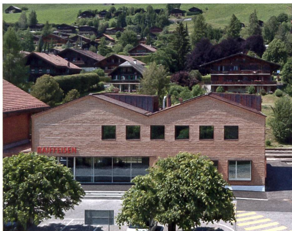
Die Raiffeisenbank Pays-d'Enhaut fügt sich ins Ortsbild ein.
