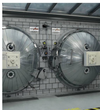
Impianto Papersave swiss, Wimmis. Entrambe le camere sono chiuse, l'impianto è in funzione.
