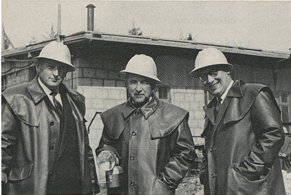
Construction d'un tunnel à double voie, de 4 km de longueur, entre Weesen et Mühlehorn (lac de Walenstadt)
