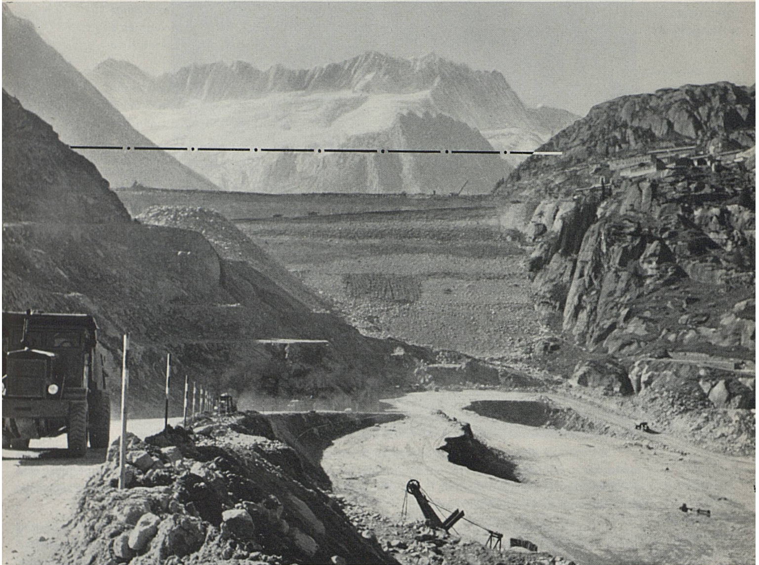
Digue de la grande centrale de Göschenen. Vue de la colline de matériaux, du côté du parement aval. A droite, en haut, les baraquements. La ligne pointillée indique la hauteur de la crête de la digue.
