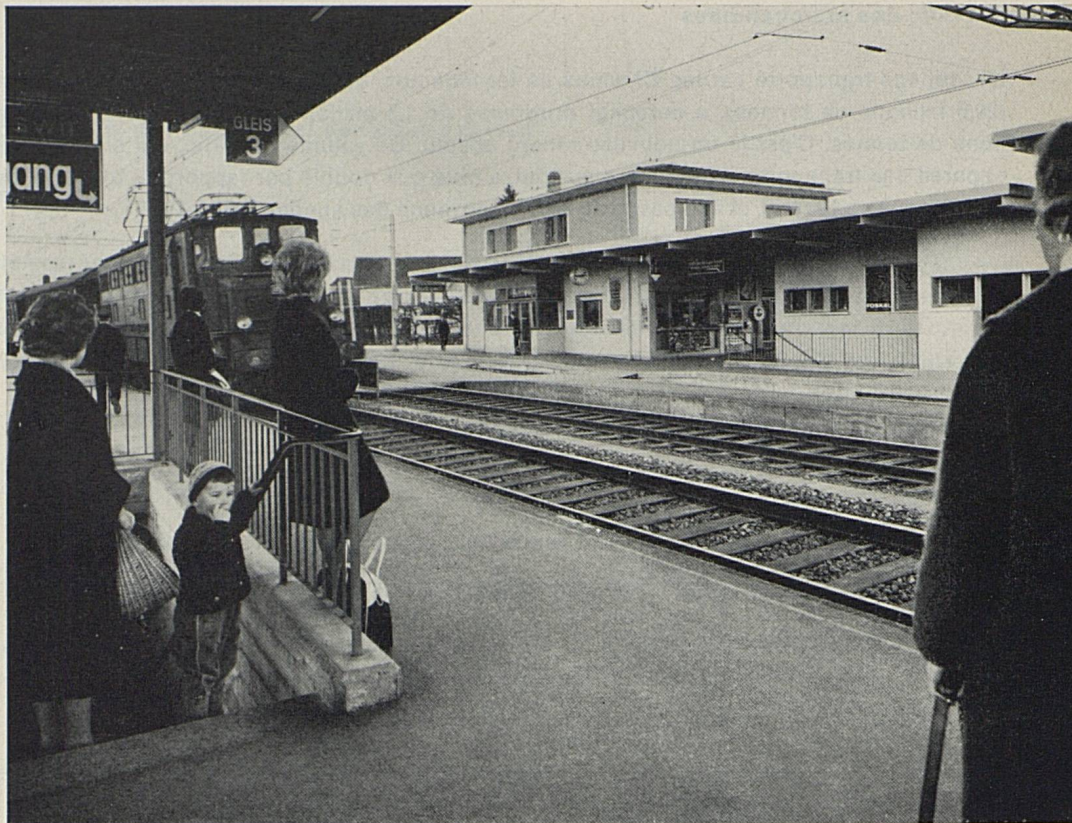
Le nouveau bâtiment de gare de Busswil
