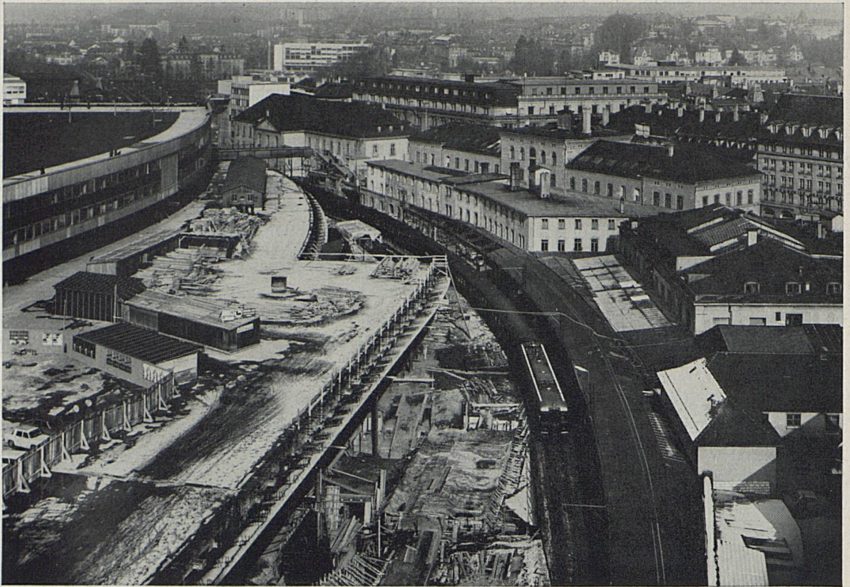
Reconstruction de la gare de Berne. Bientôt, la dernière voie à quai sera, elle aussi, sous toit.
