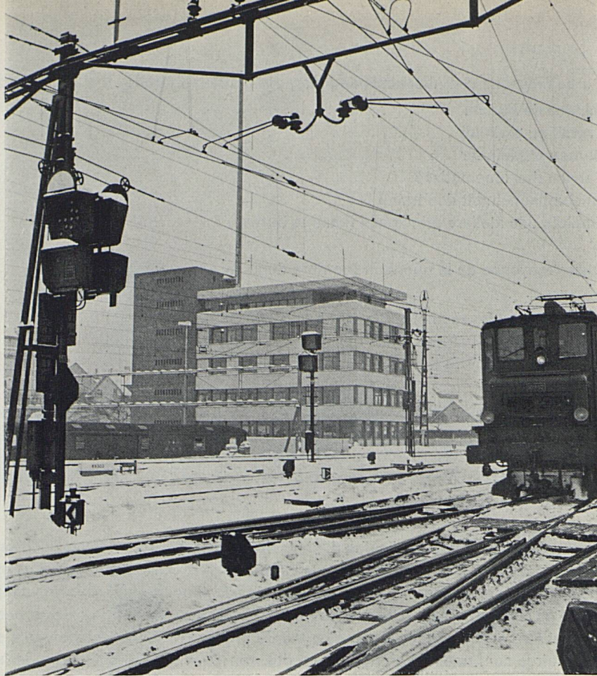
Nouveau bâtiment à la gare principale de Zurich. Cet édifice abrite notamment les bureaux de la régulation des trains et des locomotives, chargés de surveiller le trafic sur les lignes principales du III e arrondissement.
