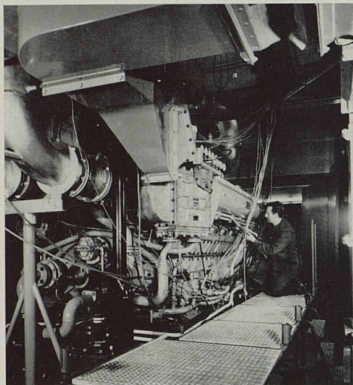
Monteur contrôlant la pompe d'injection d'un moteur diesel de 1200 CV pour locomotive Bm 4/4. Les câbles de mesure et les conduites sous pression relient le moteur au poste de commande (fig. de droite). Il est possible de suivre les variations de la température dans les cylindres, de la pression tant dans le circuit du lubrifiant que dans les presseurs de suralimentation.
