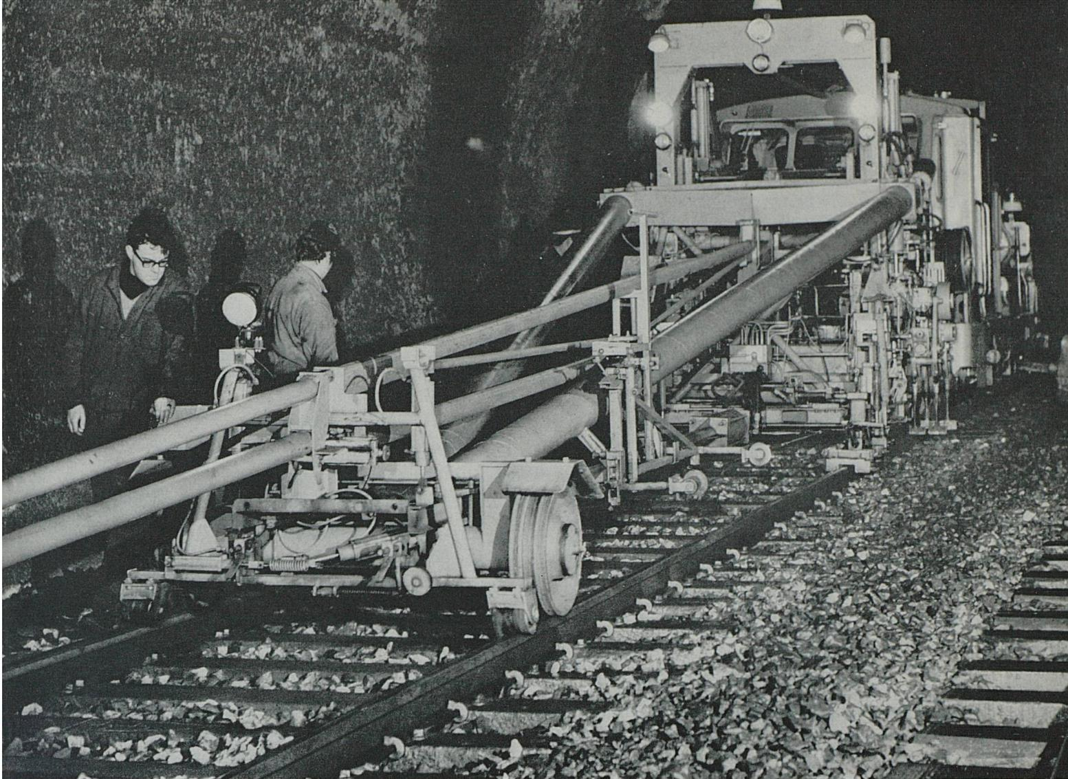
Le bourrage des traverses et la correction de l'assiette de la voie, qui étaient primitivement des travaux pénibles, nécessitant une main-d'œuvre nombreuse, sont depuis plusieurs années exécutés en grande partie à l'aide de machines modernes et puissantes. La bourreuse-niveleuse-ripeuse, conduite par trois hommes, corrige automatiquement le nivellement longitudinal, le dévers transversal et le tracé de la voie, à la vitesse de 220 m à l'heure.
