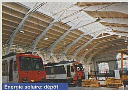
Énergie solaire: dépôt de locomotives à Berne
