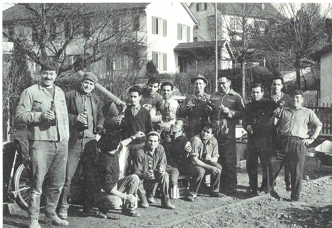
In Fronarbeit errichteten italienische Gastarbeiter während rund 4200 Arbeitsstunden die Kinderkrippe an der Scheibenbergstrasse 14.
