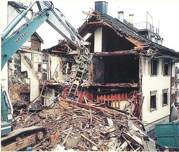
▲ Die ehemalige Bäckerei wird abgebrochen.
