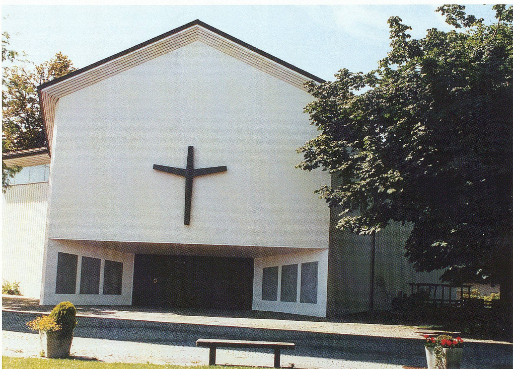
Auch die Aussenhülle wurde komplett renoviert.
