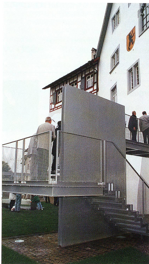
her Der neue, moderne Treppenaufgang
