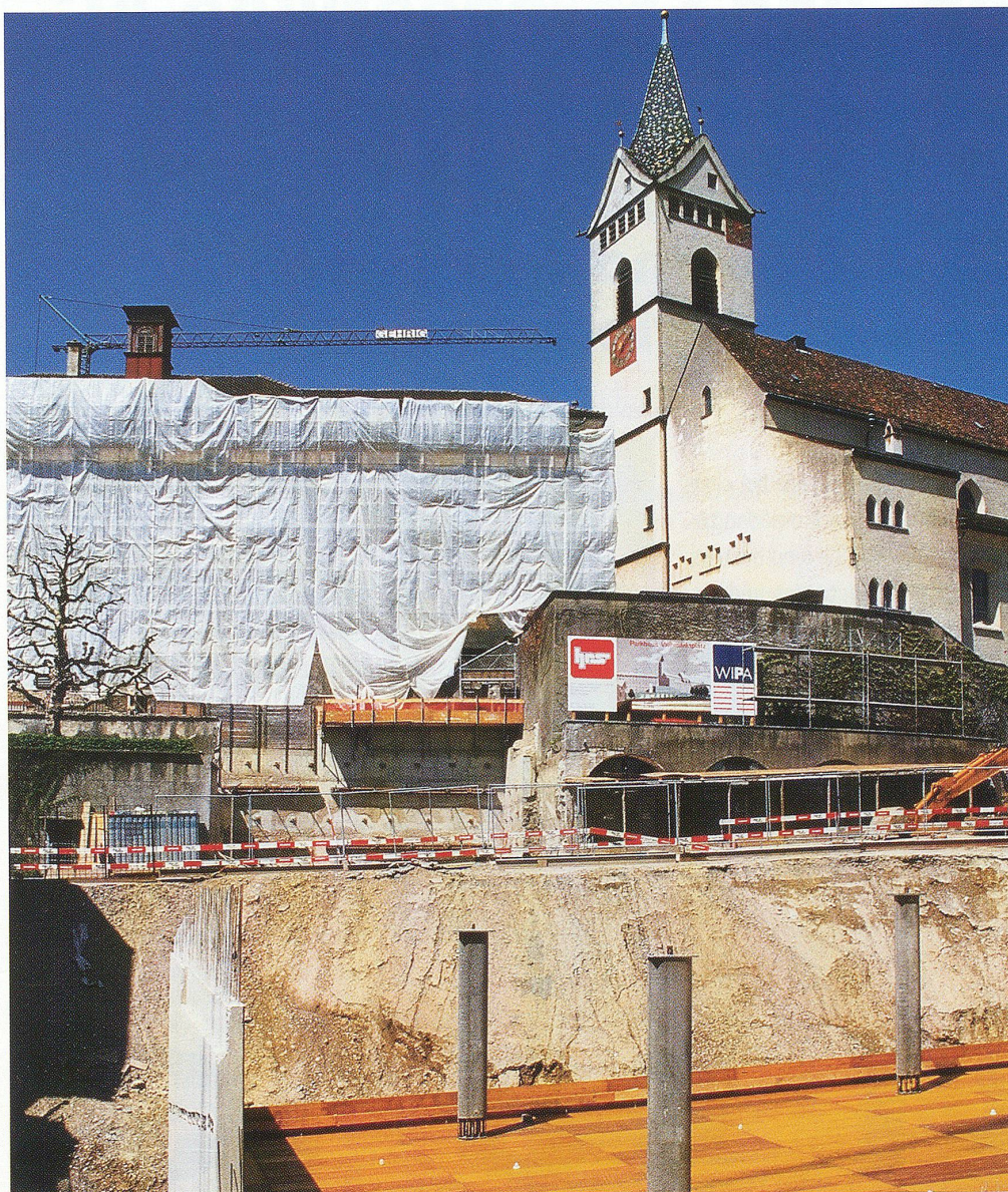
Am 4. Januar begannen die Bauarbeiten zum Parkhaus Altstadt.
