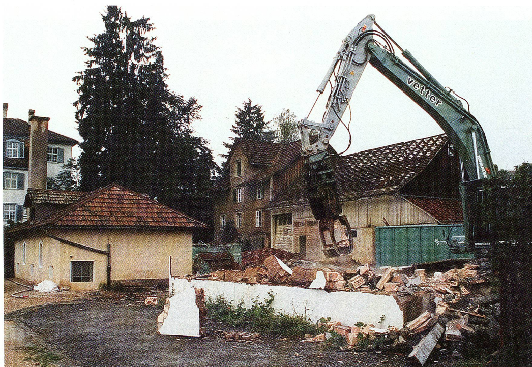
Die alten Gebäude der Bernhard-Baumschulen werden abgebrochen.
