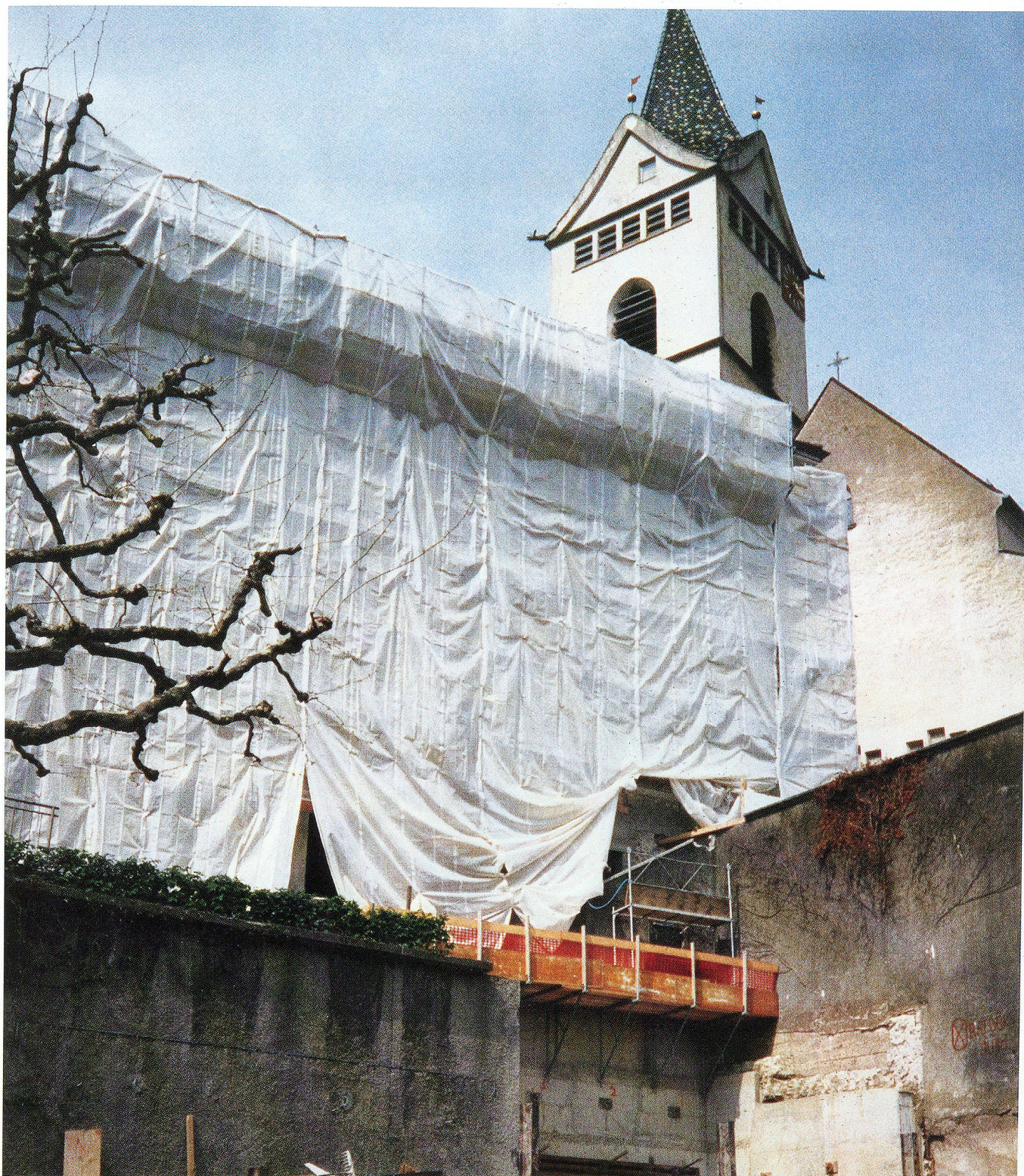
Grossbaustelle Parkhaus Altstadt
