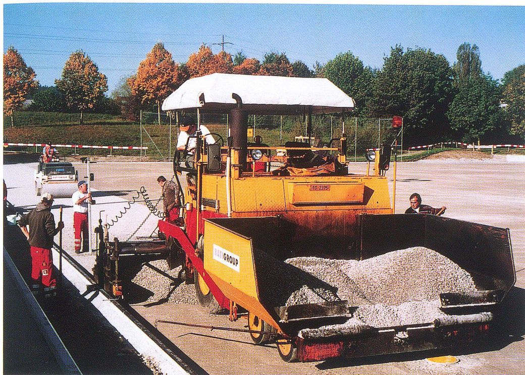
Der Split wird maschinell eingebaut
