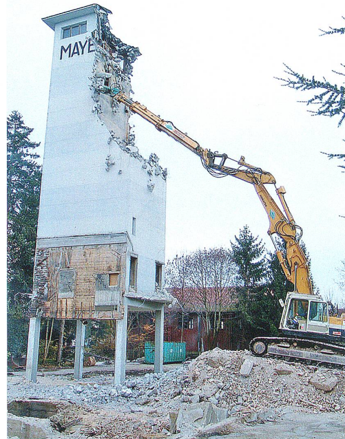
Vorsichtig bricht der Bagger Stück für Stück aus dem Turm heraus.
