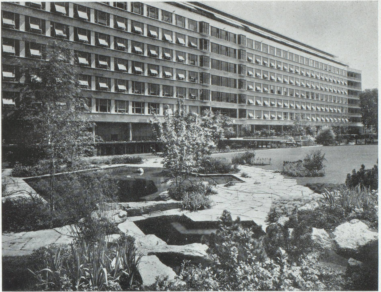
Hôpital cantonal de Bâle Architectes : MM. Baur, Brauning, Leu, Düring et Vischer.
