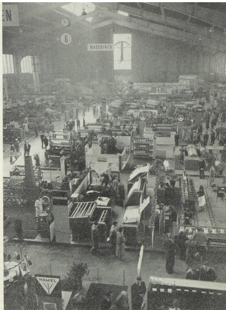
La halle aux machines
