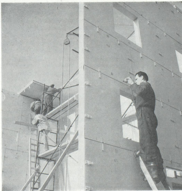
Construction isotherme pour pays chauds en sandwich mousse stratifié polyester. Réalisation U. A. C. P. (Document « Revue Industrie des Plastiques Modernes ».)
