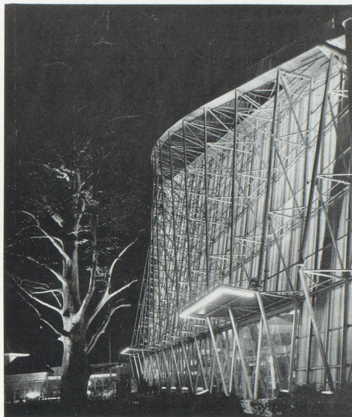
Illuminations nocturnes du Pavillon de la France à l'Exposition de Bruxelles; vue d'une des trois parois revêtues de feuilles ondulées polyesters.
