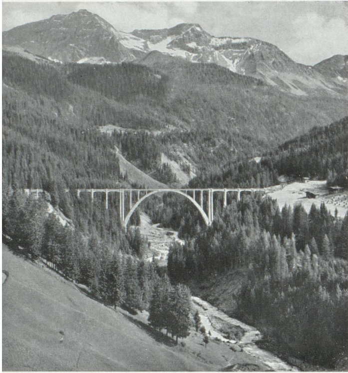
Le viaduc de Langwies, dans les Grisons (fig. 2)
