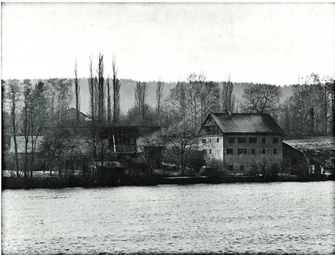
Der Hof im Augarten kurz vor dem Abbruch.
