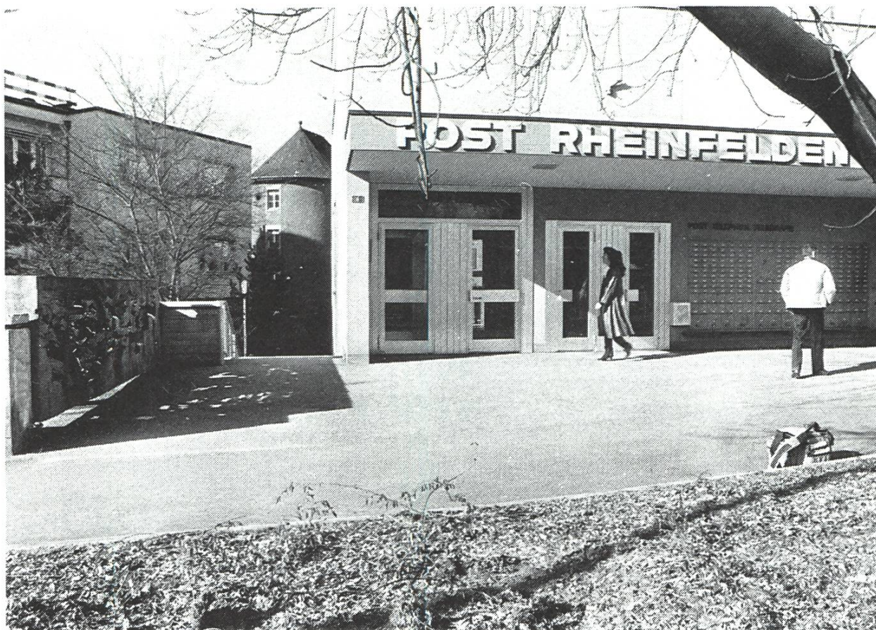
Eingang des heutigen Postgebäudes mit der Postfachanlage (1970).
