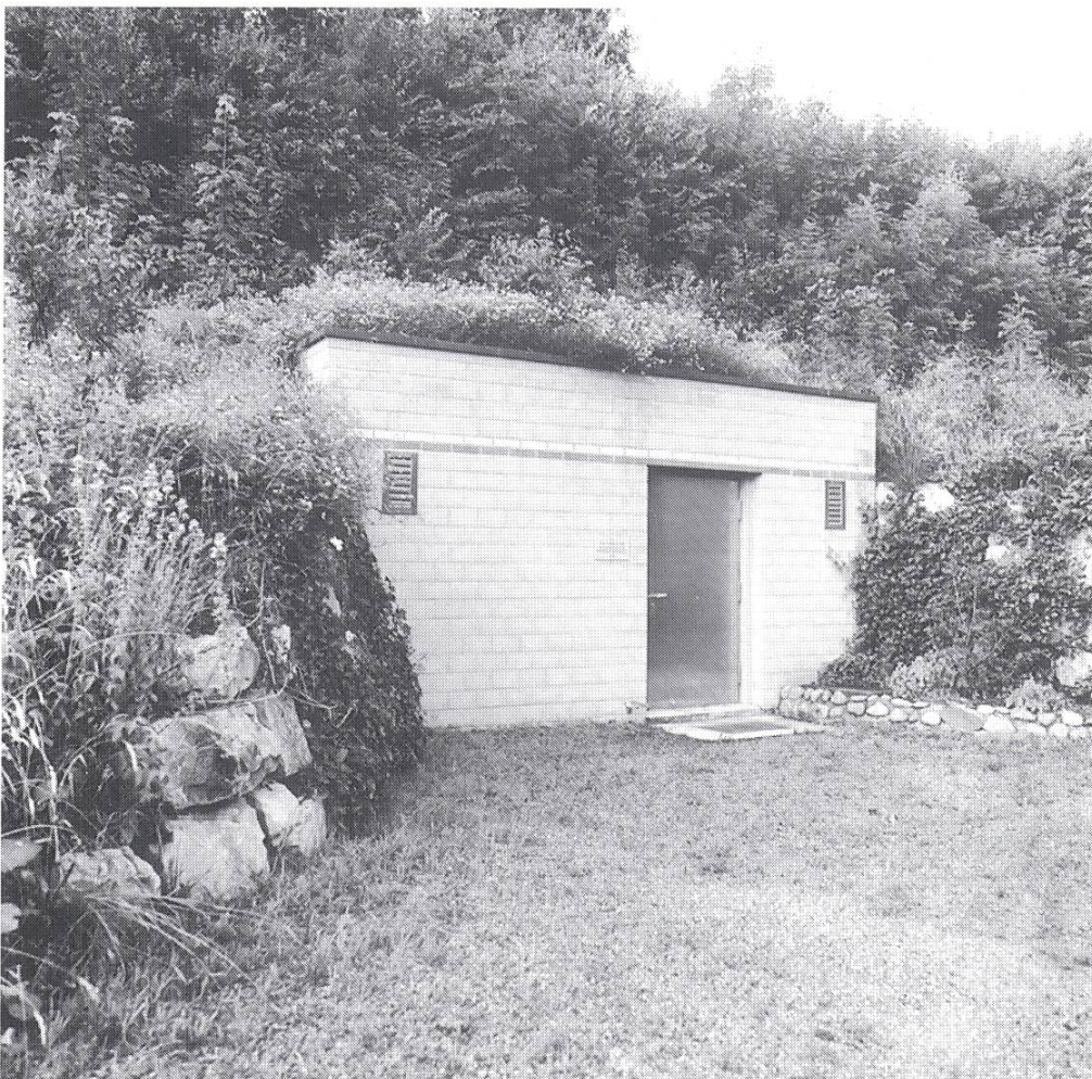
Eingang zur Quellwasserfassung Weiherfeld
