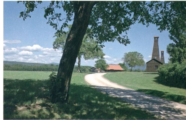
Das Betriebszentrum des Bauernhofs der Neumatt AG steht heute im Grossgrüt, Rheinfelden-Ost, nahe bei den Museums-Salzbohrtürmen.
