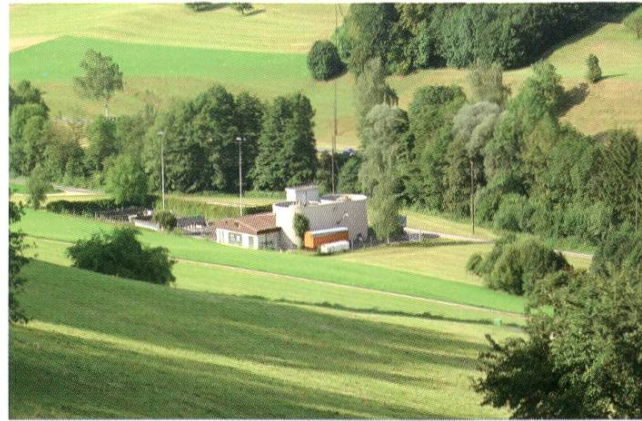
Stillgelegte Kläranlage Hellikon-Wegenstetten am 18.07.2007.
