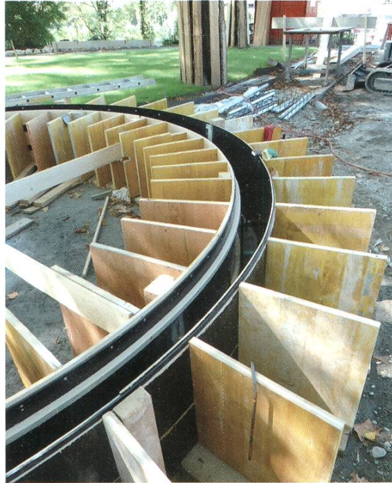
Erstellung der neuen Brunnenschale.
