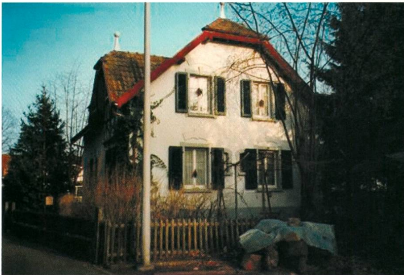
Das «Reimanne-Hüsli» an der Roberstenstrasse 14. (Quelle: Gisela Christoffel)
