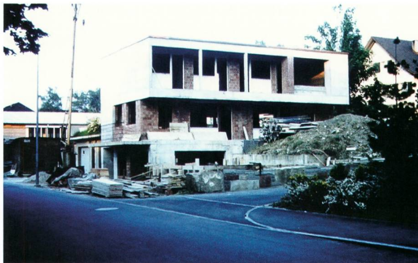
Das Haus der Familie Bieber beim Bau 1965. (Quelle: Markus Bieber)
