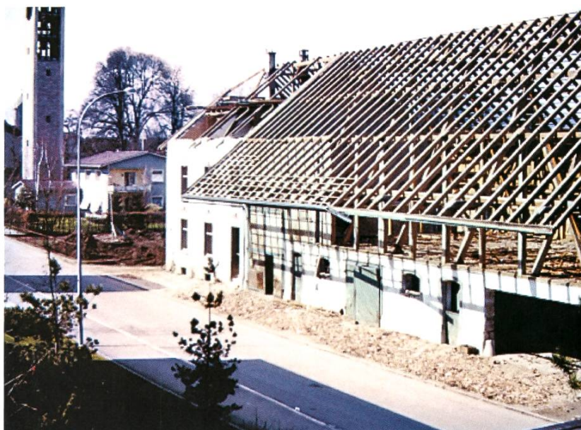
Der Lindenhof kurz vor seinem Abriss. (Quelle: Markus Bieber)
