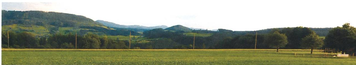
Abb. 7 Heutige 16'000 Volt-Leitung auf der Hochebene Wabrig ob Hellikon auf dem Trasse der historischen ersten 25'000 Volt-Verbundleitung zwischen den Kraftwerken Beznau und Rheinfelden. Dient heute der Versorgung der Gemeinden des Wegenstettertals und von Schupfart (Photo: K. Beretta)
