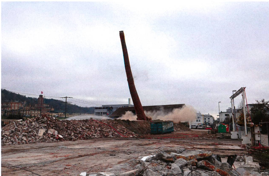
Die Sprengung des Hochkamins der ehemaligen Fassfabrik im November 2018
