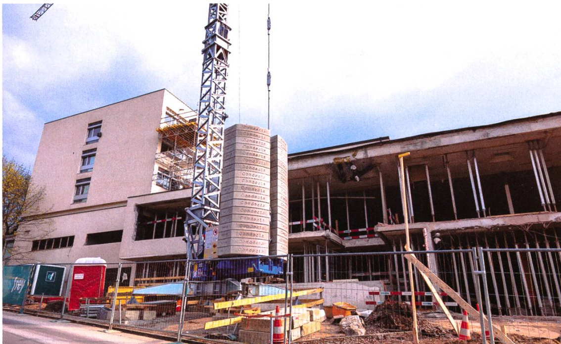
Massive Eingriffe in die Bausubstanz lassen aus dunklen Laden- und Lagerräumen eine lichtdurchflutete Schul-, Bewegungs- und Aufenthaltsinfrastruktur erblühen
