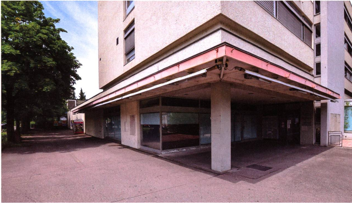
Gähnende Leere, kurz vor dem Start zum Umbau
