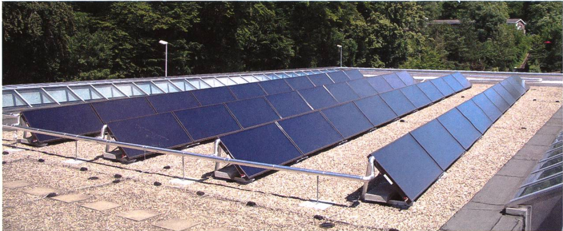
Installation Solaranlage auf dem Dach Therapiebad, 2008
