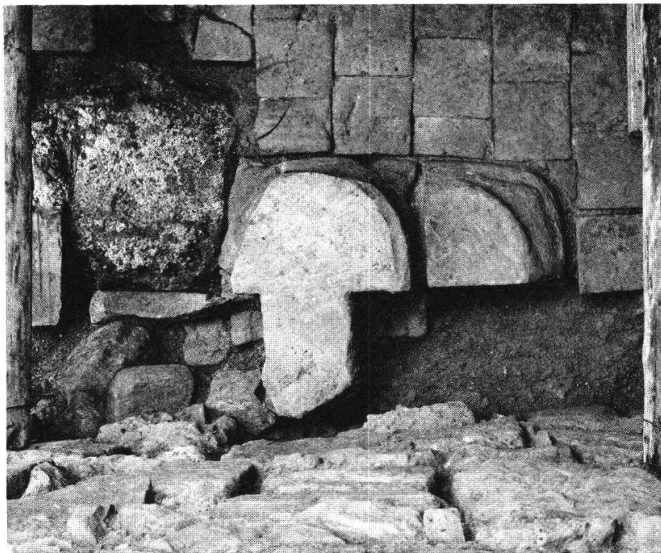
Fig. 5. Vestiges du pilier engagé, à l'angle entre le croisillon sud et le collatéral sud. A droite en haut, le sol recouvert de carreaux en terre cuite du XV e s.
